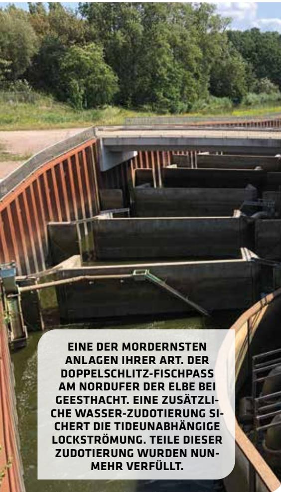
**EINE DER MORDERNSTEN ANLAGEN IHRER ART. DER DOPPELSCHLITZ-FISCHPASS AM NORDUFER DER ELBE BEI GEESTHACHT. EINE ZUSÄTZLICHE WASSER-ZUDOTIERUNG SICHERT DIE TIDEUNABHÄNGIGE LOCKSTRÖMUNG. TEILE DIESER ZUDOTIERUNG WURDEN NUNMEHR VERFÜLLT.**
