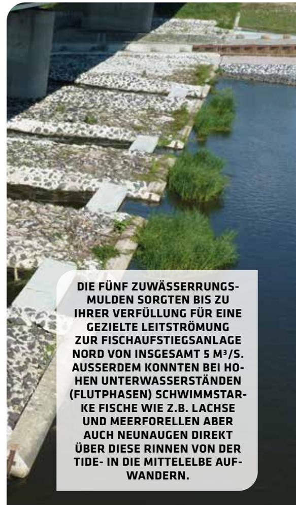
**DIE FÜNF ZUWÄSSERUNGSMULDEN SORGTEN BIS ZU IHRER VERFÜLLUNG FÜR EINE GEZIELTE LEITSTRÖMUNG ZUR FISCHAUFSTIEGSANLAGE NORD VON INSGESAMT 5 M<sup>3</sup>/S. AUSSERDEM KONNTEN BEI HOHEN UNTERWASSERSTÄNDEN (FLUTPHASEN) SCHWIMMSTARKE FISCHE WIE Z.B. LACHSE UND MEERFORELLEN ABER AUCH NEUNAUGEN DIREKT ÜBER DIESE RINNEN VON DER TIDE- IN DIE MITTEL-ELBE AUFWANDERN.**
